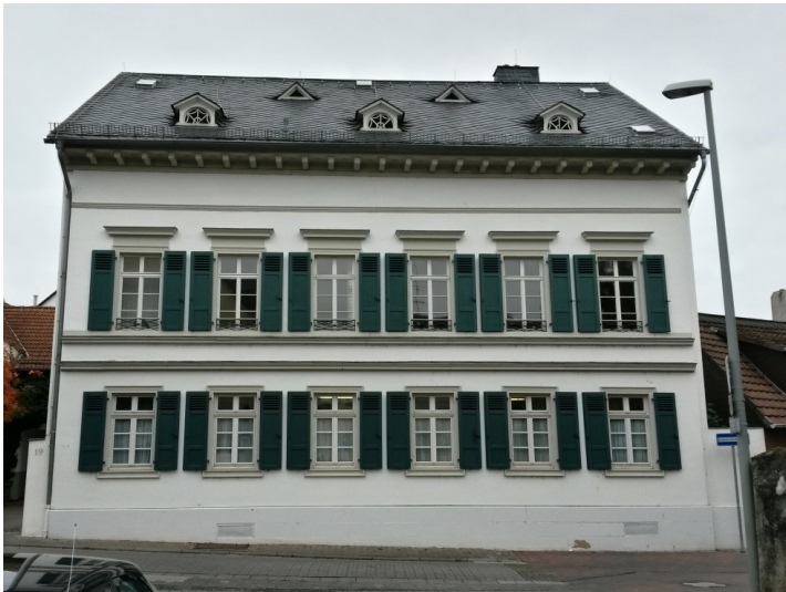
Institutsgebäude Kellerwirtschaft-Weinbau in Geisenheim Fotograf/Urheber: Aidexx
