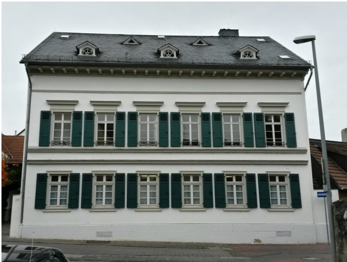
Institutsgebäude Kellerwirtschaft-Weinbau in Geisenheim Fotograf/Urheber: Aidexx
