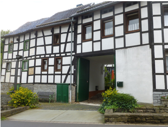
Fachwerkhof in Eiserfey (2014) Fotograf/Urheber: Annette Schwabe
