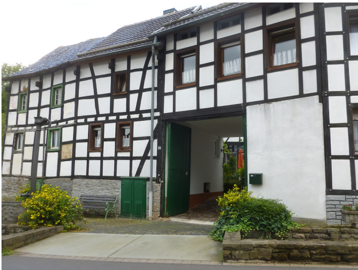
Fachwerkhof in Eiserfey (2014) Fotograf/Urheber: Annette Schwabe
