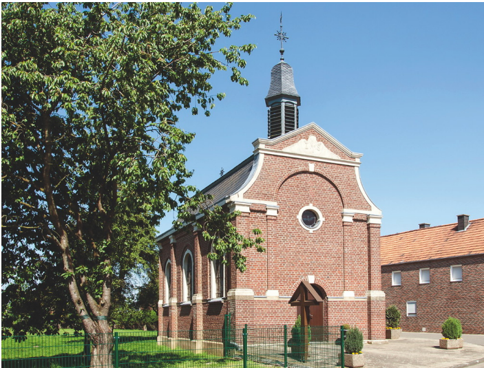
Kapelle in Berverath Fotograf/Urheber: Franke Michael
