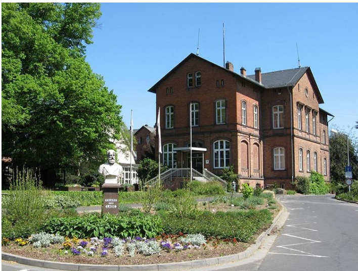
Verwaltungsgebäude der Hochschule Geisenheim University
