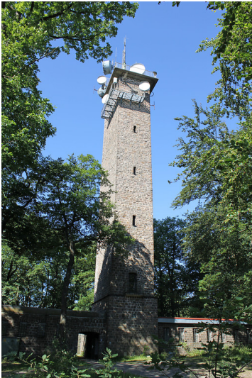
Ansicht des Potzbergturms bei Föckelberg. Auf dem Dach befinden sich Sendeeinrichtungen (2011). Fotograf/Urheber: Werner Lademann
