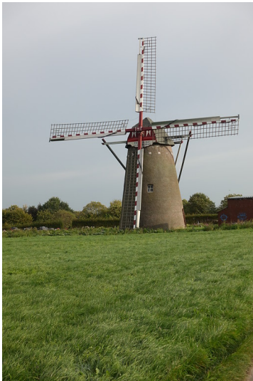
Windmühle Waldfeucht (2017) Fotograf/Urheber: Axel Welp
