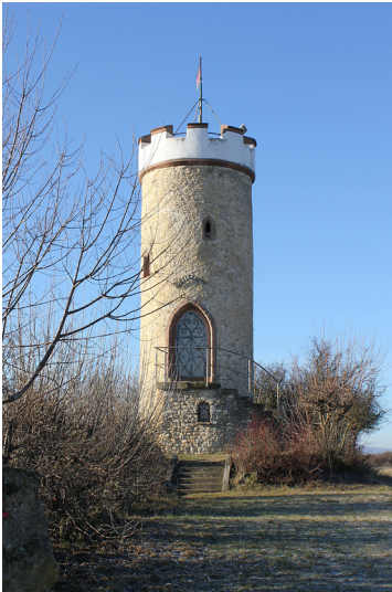
Portalansicht des Wartturms bei Albisheim (2012). Fotograf/Urheber: Werner Lademann
