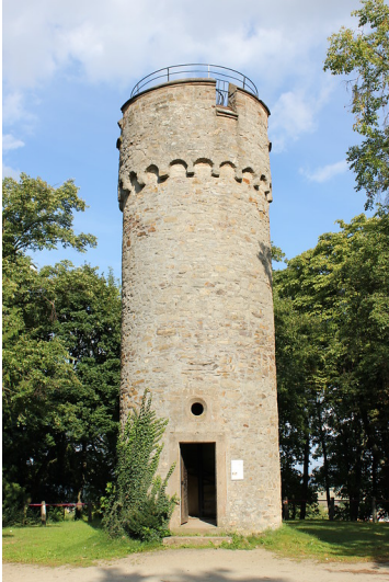
Ansicht des Wartturms auf dem Gelände des Schillerhains in Kirchheimbolanden (2010). Fotograf/Urheber: Werner Lademann
