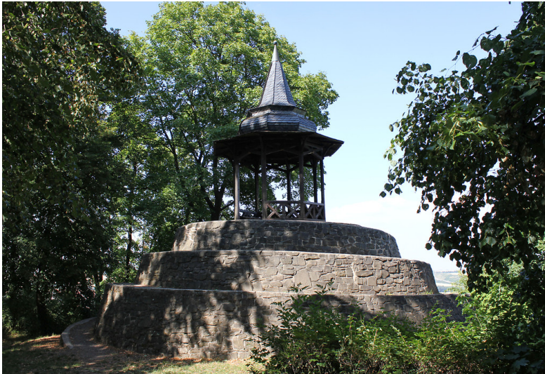
Das Schnecken türmchen im Schillerhain auf dem Wartberg bei Kirchheimbolanden (2011). Drei Windungen führen nach oben zu einem aufgesetzten hölzernen Pavillon. Fotograf/Urheber: Werner Lademann
