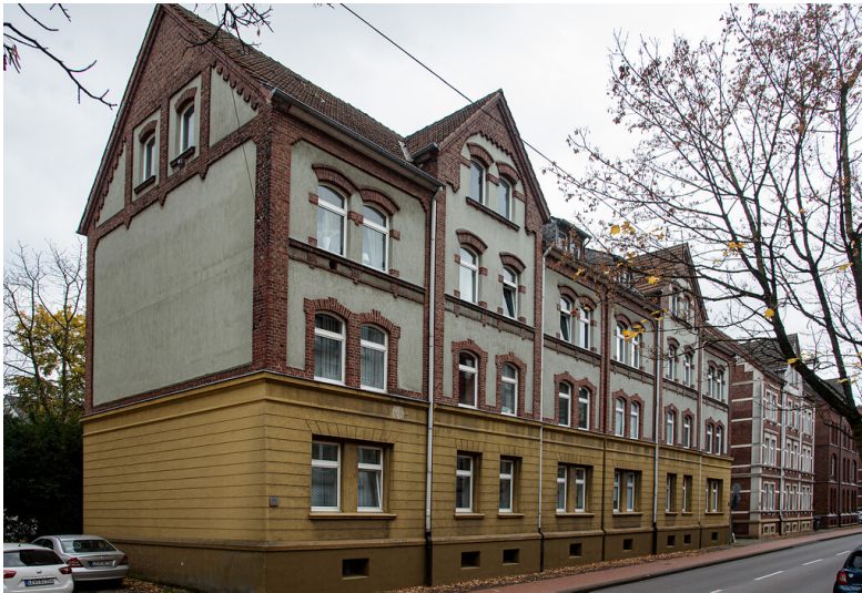
Eisenbahnersiedlung an der Humboldtstraße Opladen (2021) Fotograf/Urheber: Willy Borgfeldt
