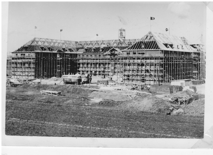
Richtfest des Marinelazaretts in Engelbrechtsche Wildnis am 18.04.1939
