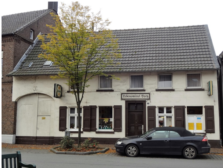
Wohn- und Geschäftshaus am Kapellener Markt 16 in Geldern (2017) Fotograf/Urheber: Helga M. Kaczmarek
