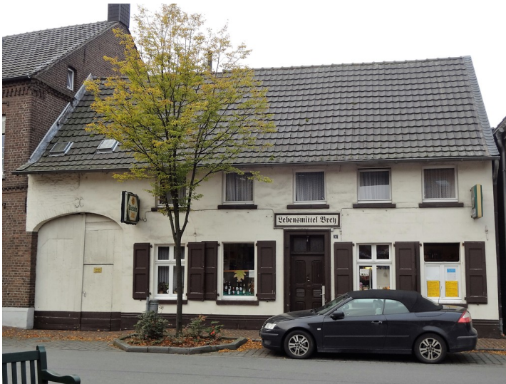
Wohn- und Geschäftshaus am Kapellener Markt 16 in Geldern (2017) Fotograf/Urheber: Helga M. Kaczmarek
