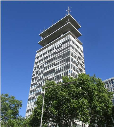
Das Telekom-Hochhaus in der Sternengasse in Köln-Altstadt-Süd (2019) Fotograf/Urheber: Franz-Josef Knöchel
