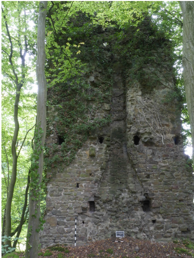
Wasserburg Bernsau bei Overath, Blick auf aufgehendes Mauerwerk mit einem Kamin (2017) Fotograf/Urheber: Michael Gran
