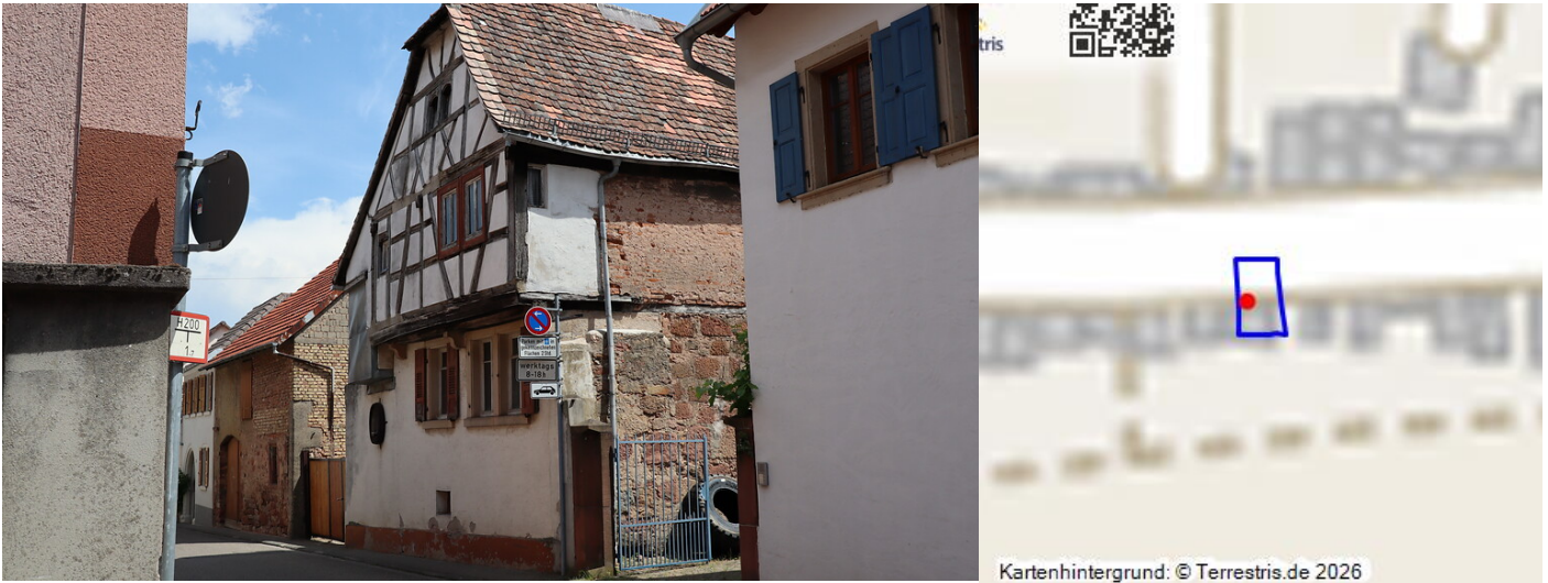
Fachwerkhaus Hauptstraße 39 in Alsterweiler (2020) Fotograf/Urheber: Lucy Liebe
