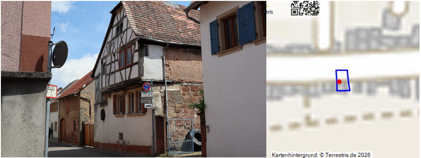
Fachwerkhaus Hauptstraße 39 in Alsterweiler (2020) Fotograf/Urheber: Lucy Liebe
