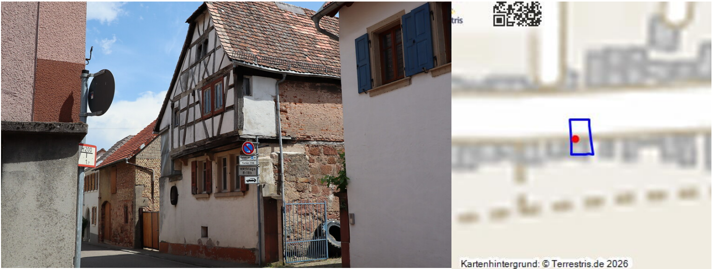
Fachwerkhaus Hauptstraße 39 in Alsterweiler (2020) Fotograf/Urheber: Lucy Liebe
