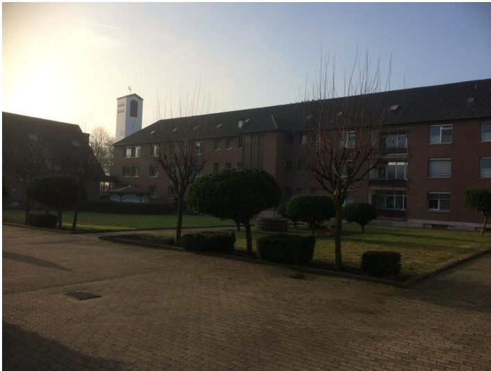
Petrusheim Weeze (2016) Fotograf/Urheber: Petrusheim Weeze
