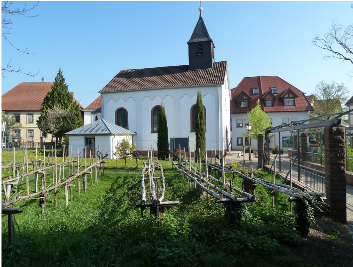
Gesamtansicht der Kapelle in Alsterweiler von Süden (2017). Fotograf/Urheber: Matthias C.S. Dreyer
