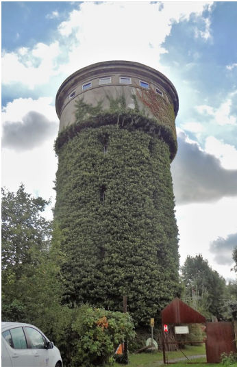
Ehemaliger Wasserturm in Geldern (2017) Fotograf/Urheber: Helga M. Kaczmarek
