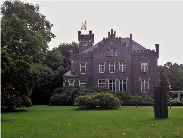
Villa von Eerde in Geldern (2017) Fotograf/Urheber: Helga M. Kaczmarek
