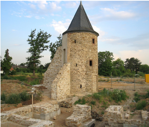
Die Obere Burg in Kuchenheim, Eckturm. Im Vordergrund Fundamente der Brückenpfeiler (2017). Fotograf/Urheber: Riza Smani
