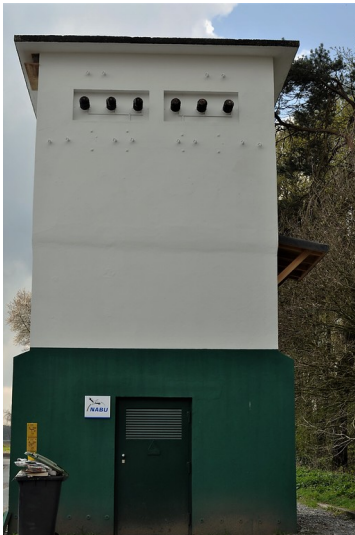
Trafoturm in Straelen-Broekhuysen (2012) Fotograf/Urheber: Monika Hertel
