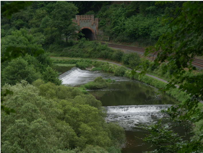
Schleuseninsel Kirschhofen bei Weilburg an der Lahn, die an die Insel anschließenden Schleusenwehre sowie das südliche Portal des Kirschhofener Eisenbahntunnels (2017) Fotograf/Urheber: Jörn Schultheiß
