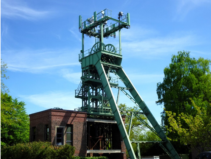
Der Förderturm der Grube Lüderich (2025). Fotograf/Urheber: Peter Schönfeld
