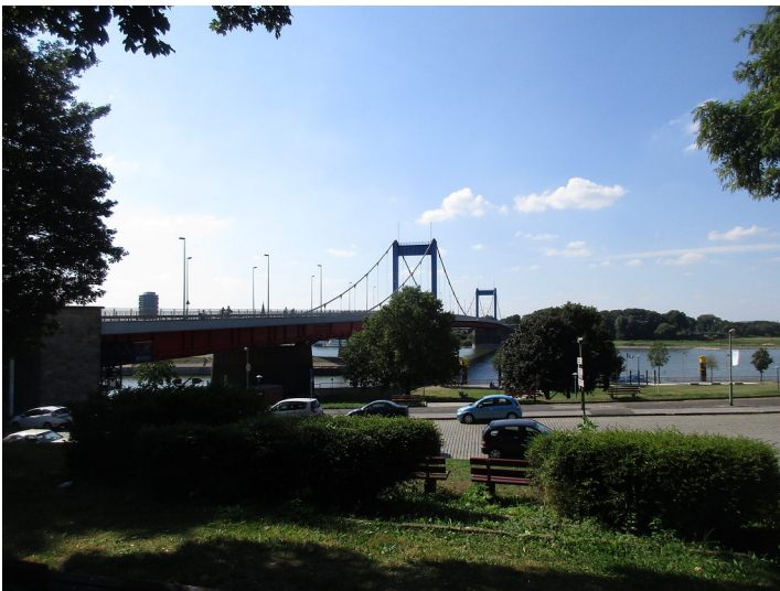
Nördliche Ansicht der Duisburger Friedrich-Ebert-Brücke (2016)
