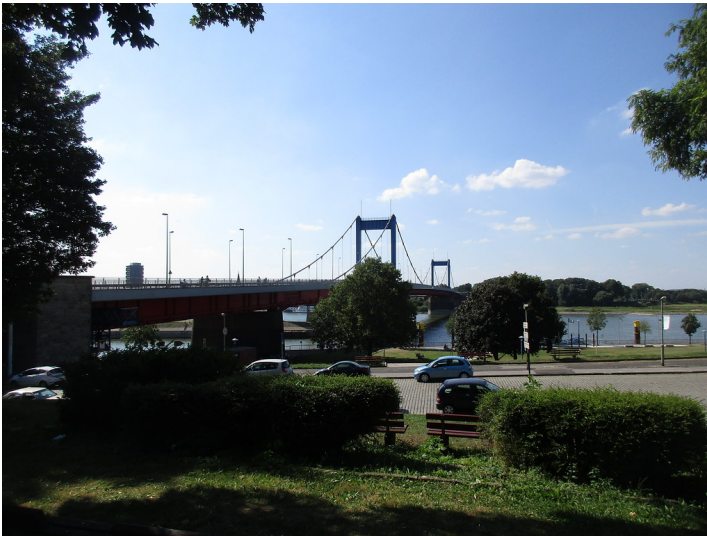
Nördliche Ansicht der Duisburger Friedrich-Ebert-Brücke (2016)
