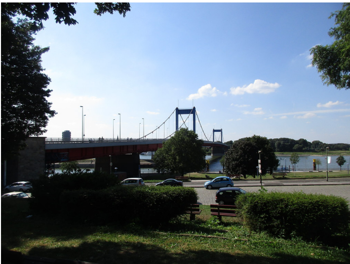
Nördliche Ansicht der Duisburger Friedrich-Ebert-Brücke (2016)
