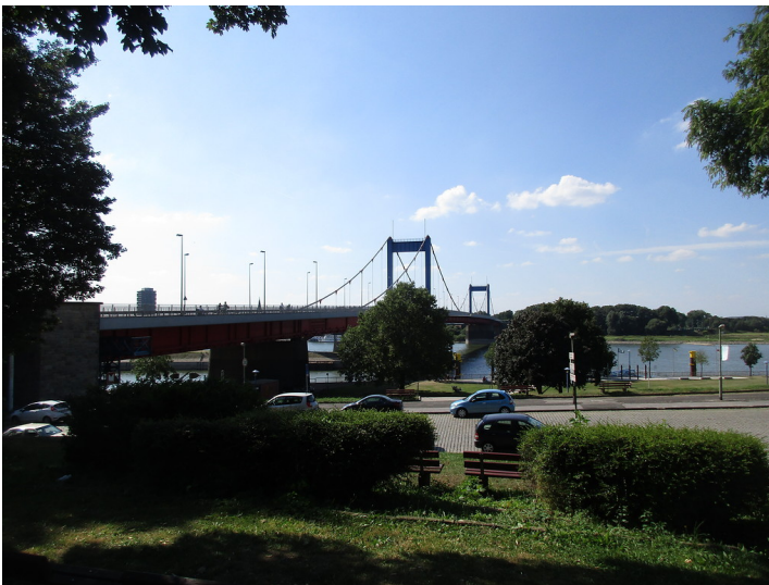
Nördliche Ansicht der Duisburger Friedrich-Ebert-Brücke (2016)
