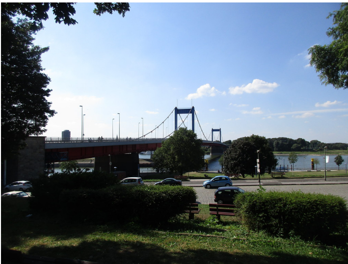
Nördliche Ansicht der Duisburger Friedrich-Ebert-Brücke (2016)
