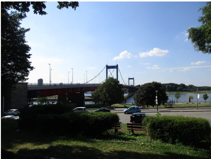
Nördliche Ansicht der Duisburger Friedrich-Ebert-Brücke (2016)
