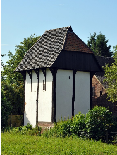
Südliche Ansicht des Berfes auf dem Raveshof in Kempen-Sankt Hubert, ein Turmspeicher mit Wehrfunktion (2017). Fotograf/Urheber: Franziska Ostfeld
