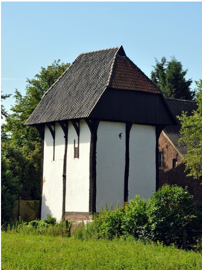
Südliche Ansicht des Berfes auf dem Raveshof in Kempen-Sankt Hubert, ein Turmspeicher mit Wehrfunktion (2017). Fotograf/Urheber: Franziska Ostfeld
