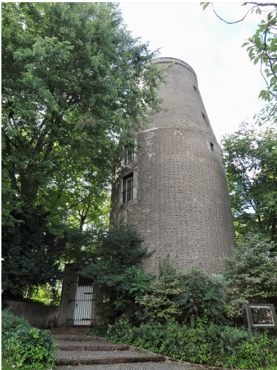
Mühlenturm und Kasematten in Geldern (2017) Fotograf/Urheber: Helga M. Kaczmarek
