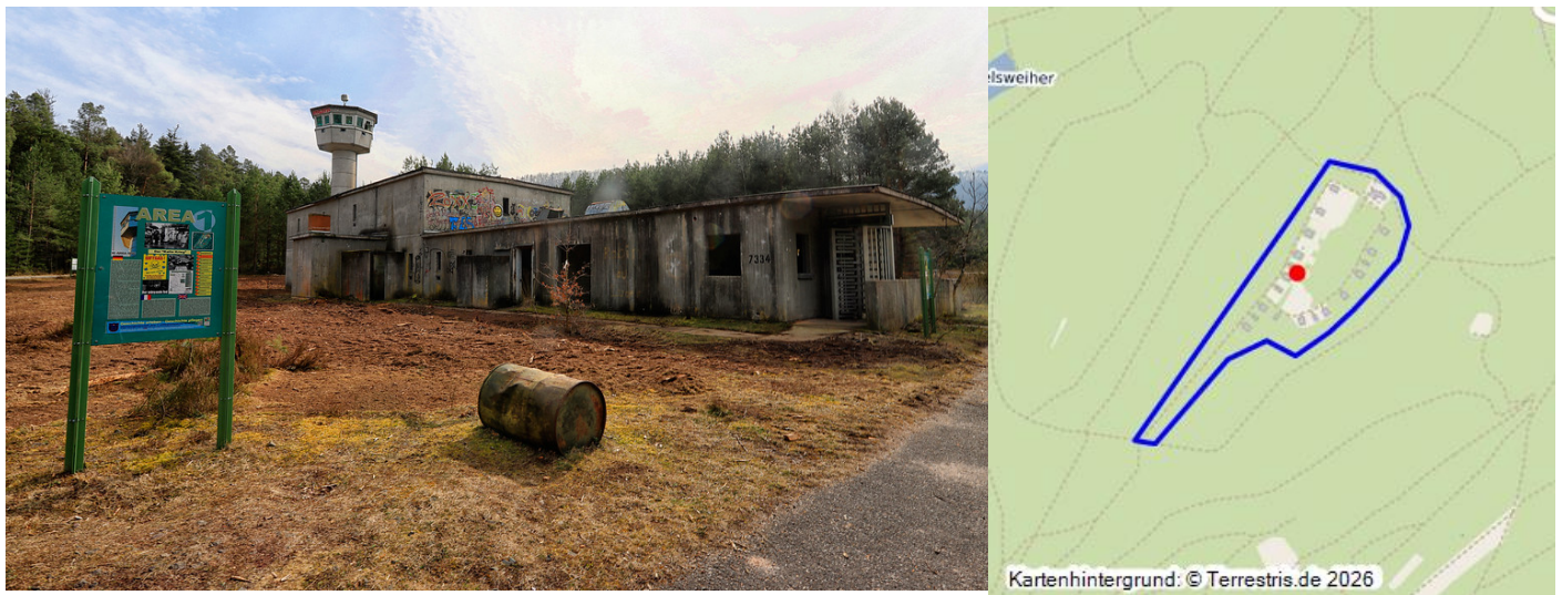
Ehemaliges US-Sonderwaffenlager Area One in Fischbach bei Dahn. Blick auf eines der heute leerstehenden Gebäude, angrenzend an den Tower. Im Vordergrund eine moderne Informationstafel sowie ein altes Metallfass (2018). Fotograf/Urheber: BERND WAGNER
