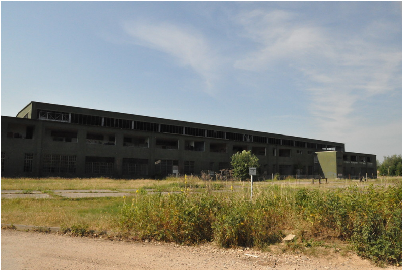
Hangar 7 RAF Wildenrath (2017) Fotograf/Urheber: Nicole Schmitz
