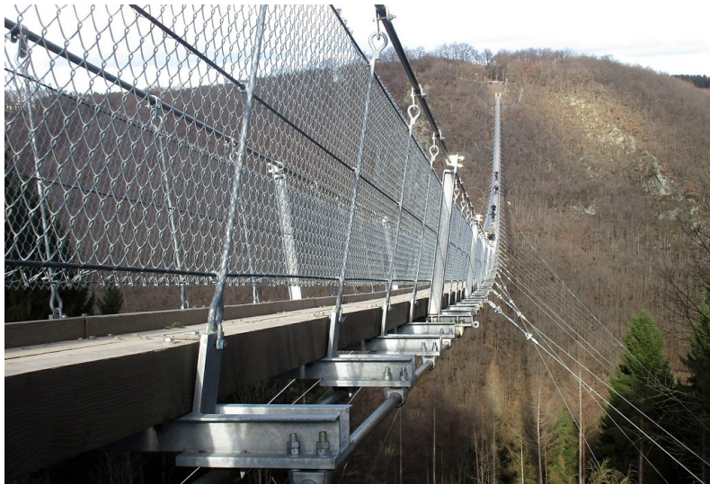
Blick über die Konstruktion der 2015 eröffneten Fußgängerseilbrücke "Geierlay" in Richtung Mörsdorf (2017).
