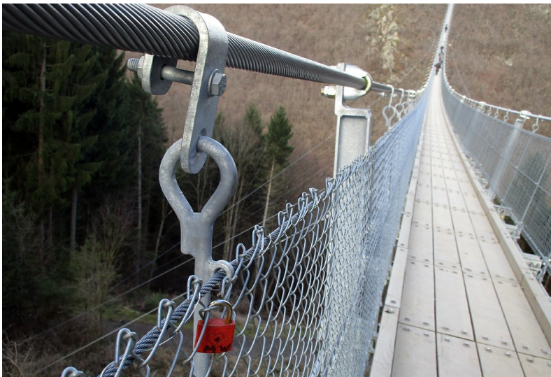
Ein einsames "Liebesschloss" an der Fußgänger-Hängeseilbrücke "Geierlay" im Hunsrück (2017). Fotograf/Urheber: Franz-Josef Knöchel
