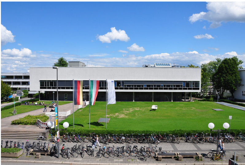
Außenansicht der Universitäts- und Landesbibliothek Bonn an der Adenauerallee (2017) Fotograf/Urheber: Franziska Ostfeld
