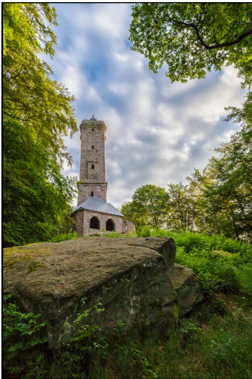
Blick auf den Luitpoldturm bei Hermersbergerhof aus östlicher Richtung (2016).
