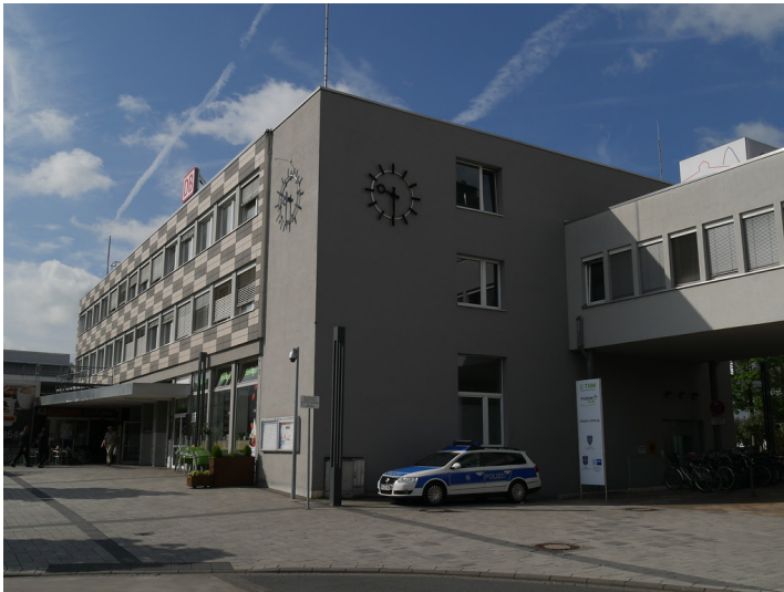
Nordansicht des Hauptgebäudes des Bahnhofs Limburg (2017) Fotograf/Urheber: Jörn Schultheiß
