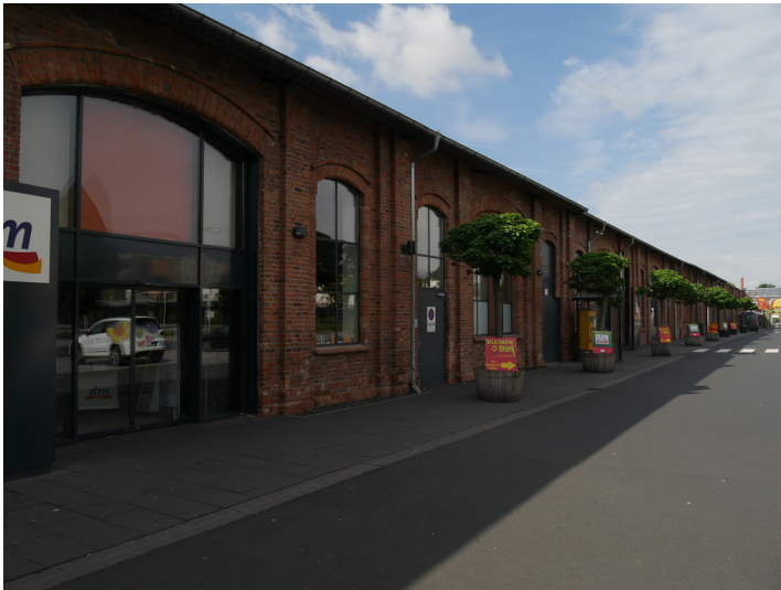
Nördliche Außenfassade der ehemaligen Richthalle des Bahnausbesserungswerkes Limburg (2017) Fotograf/Urheber: Jörn Schultheiß
