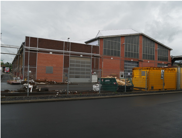
Gebäude auf dem noch durch die Bahn genutzten Areal des ehemaligen Bahnausbesserungswerkes in Limburg (2017) Fotograf/Urheber: Jörn Schultheiß
