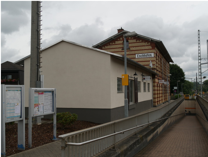
Südöstliche Ansicht des Güterschuppens (Vordergrund) sowie des Hauptgebäudes (Hintergrund) des Bahnhofs Limburg-Eschhofen (2017) Fotograf/Urheber: Jörn Schultheiß
