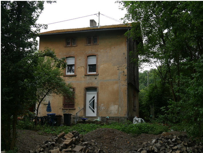
Südansicht des Streckenwärterhauses in Runkel (2017) Fotograf/Urheber: Jörn Schultheiß
