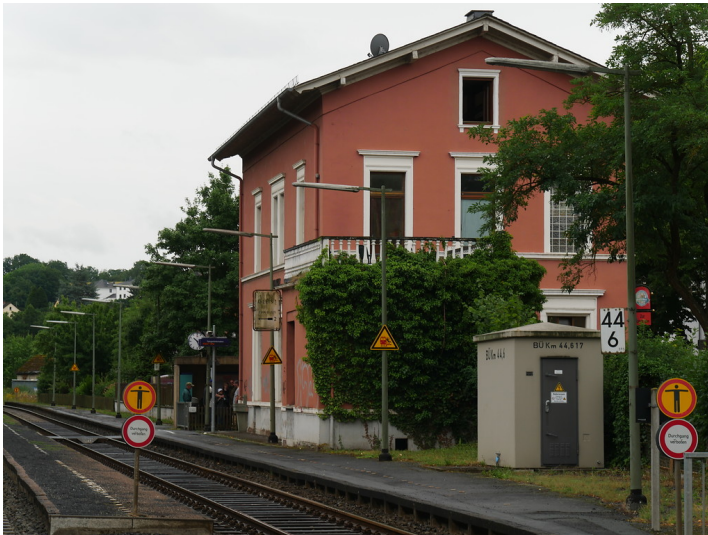
Hauptgebäude des Bahnhofs Runkel (2017) Fotograf/Urheber: Jörn Schultheiß
