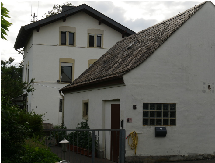
Ostansicht des Streckenwärterhauses bei Villmar (2017) Fotograf/Urheber: Jörn Schultheiß
