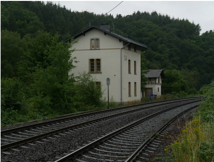
Nordansicht des Streckenwärterhauses bei Runkel-Arfurt (2017) Fotograf/Urheber: Jörn Schultheiß
