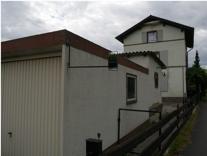
Streckenwärterhaus mit Garage bei Villmar-Aumenau (2017) Fotograf/Urheber: Jörn Schultheiß
