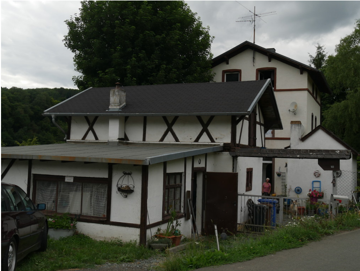
Gebäude des Bahnhofs Schafstall bei Villmar-Aumenau (2017) Fotograf/Urheber: Jörn Schultheiß
