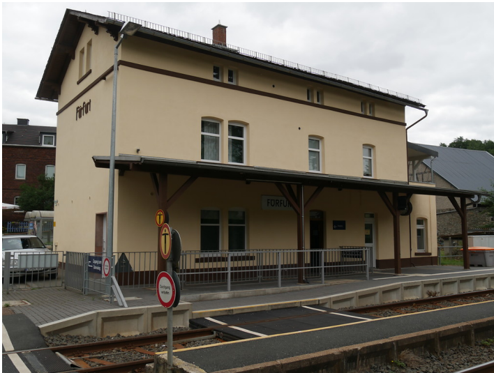
Westseite des Bahnhofsgebäudes in Weinbach-Fürfurt (2017) Fotograf/Urheber: Jörn Schultheiß
