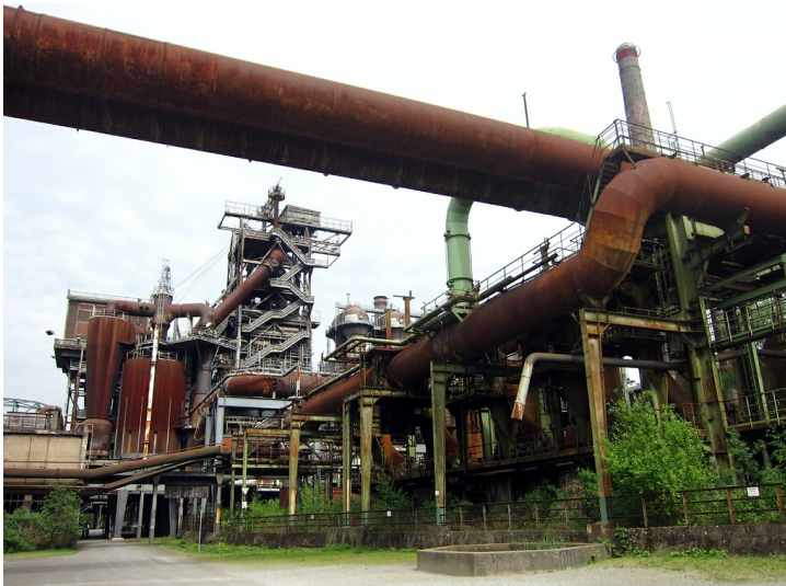
Ehemalige Hochofenanlage im heutigen Landschaftspark Duisburg-Nord (2014). Fotograf/Urheber: Franz-Josef Knöchel
