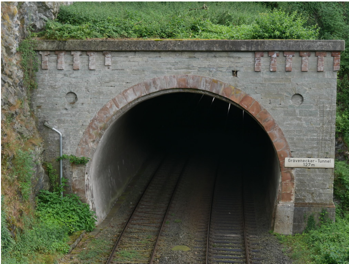
Nordportal des Gräveneck-Tunnels bei Weinbach-Gräveneck (2017) Fotograf/Urheber: Jörn Schultheiß
