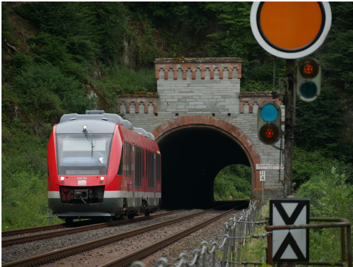
Nordportal des Schmiedskopf-Tunnels bei Weilburg-Kirschhofen (2017) Fotograf/Urheber: Jörn Schultheiß
